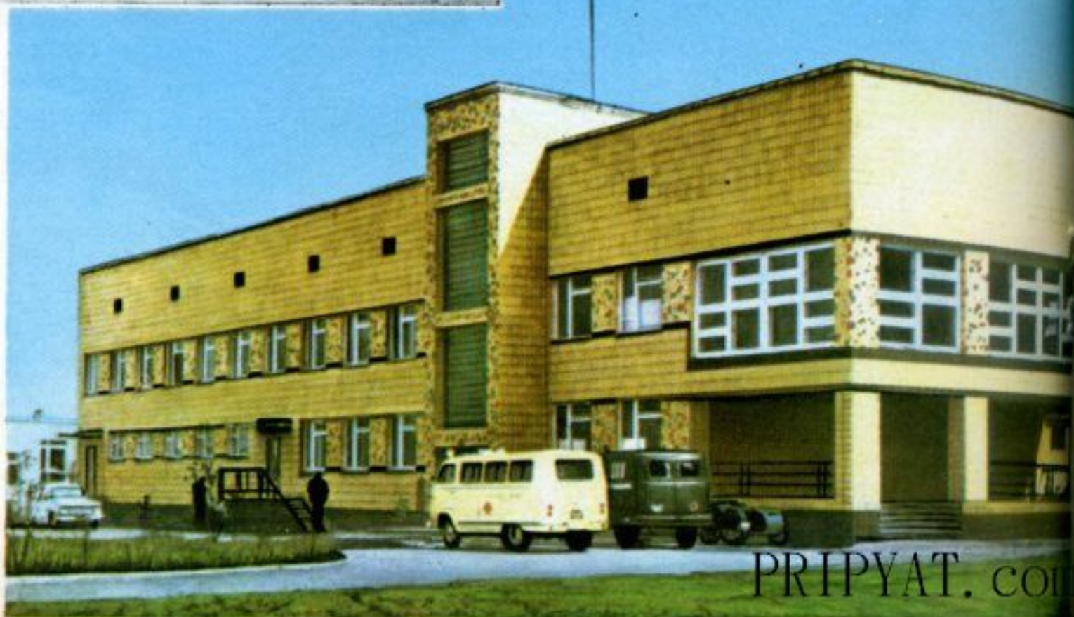
ПУНКТ СКОРОЙ ПОМОЩИ, ВХОДЯЩИЙ В ОБЩИЙ БОЛЬНИЧНЫЙ КОМПЛЕКС
