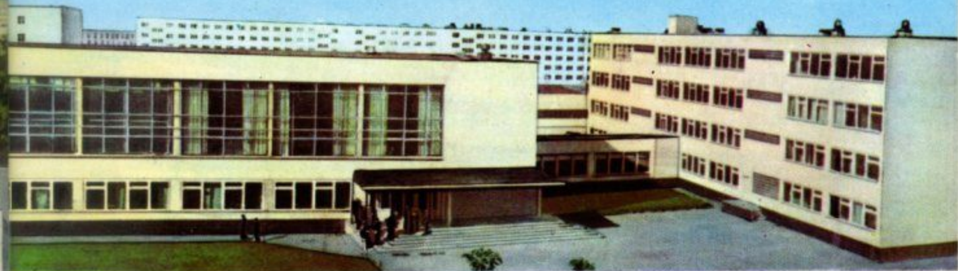
ЗДАНИЕ УЧЕБНОГО КОМПЛЕКСА ПТУ, ГОТОВЯЩЕГО РАБОЧИЕ КАДРЫ ДЛЯ АЭС
